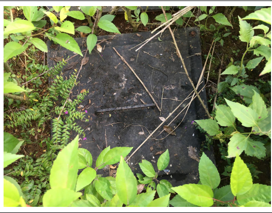
项目内化粪池
