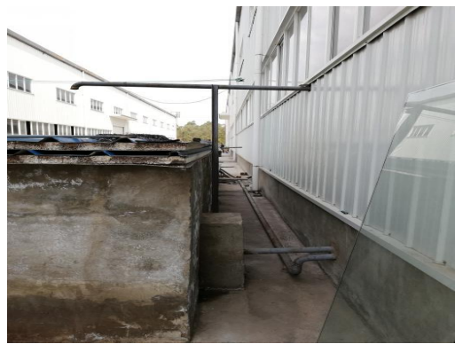
高压釜外循环水池
